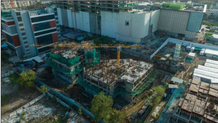
YASHWIN NUOVOCENTRO - 'A' & 'B' BUILDING
